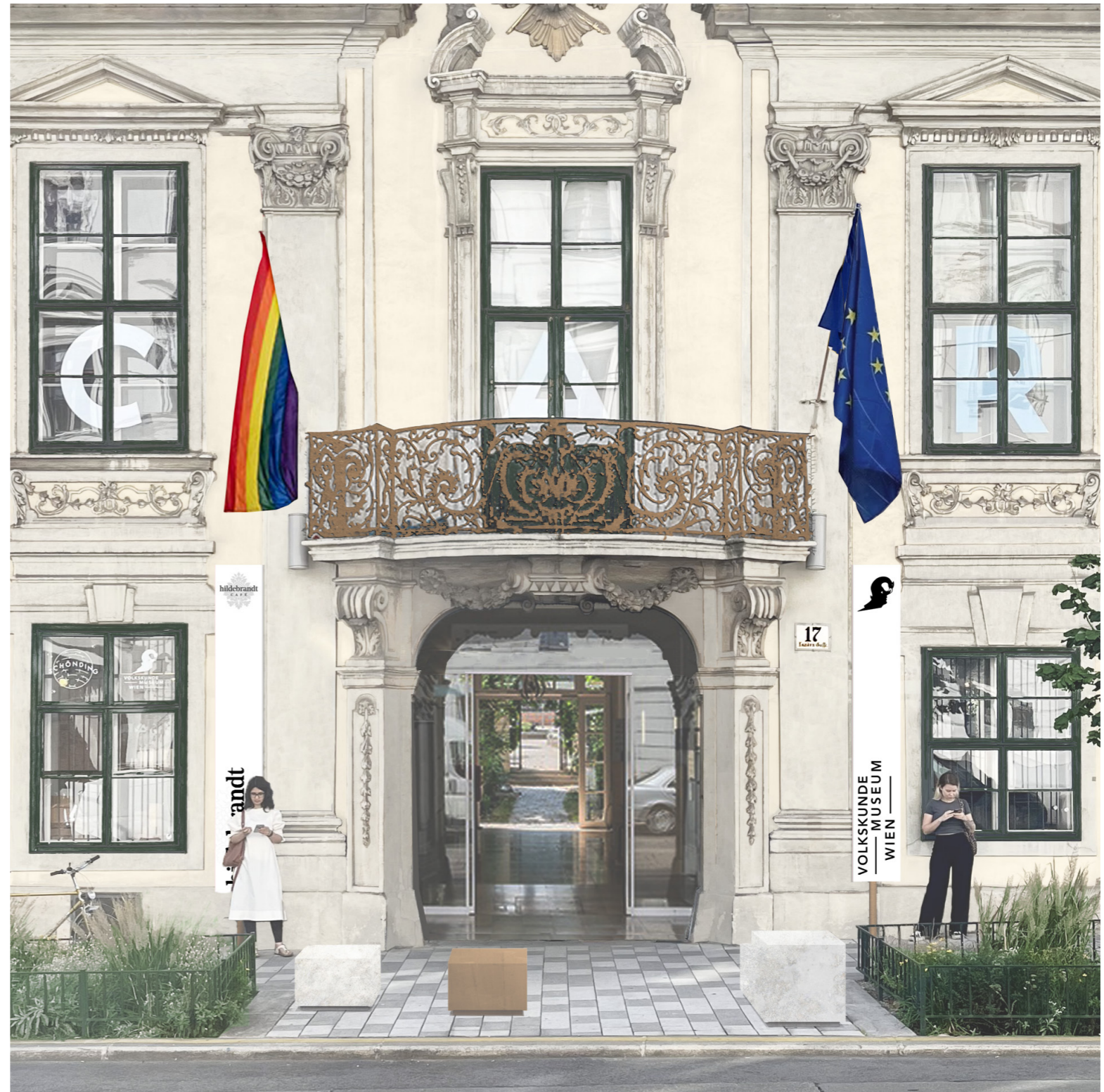
Sanierung Volkskundemuseum Wien 1080 Wien, Laudongasse 15-19
