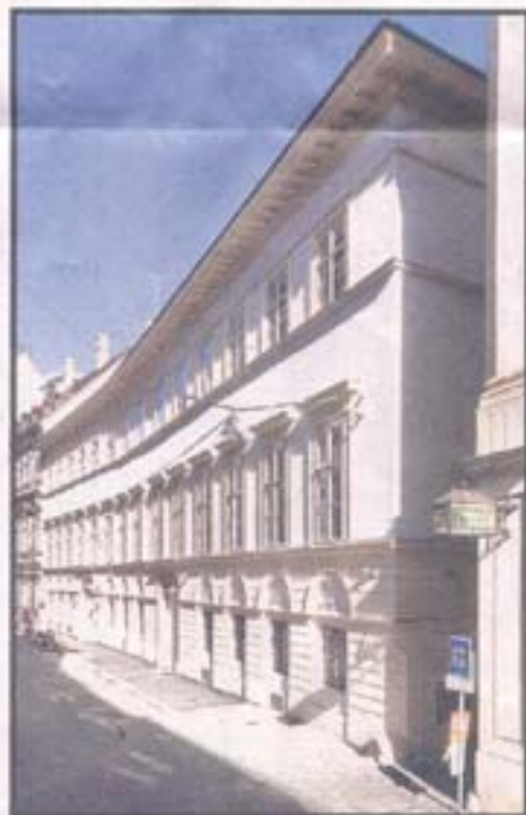
... und die historische Fassade zur Wallnerstraße, Wien I.
